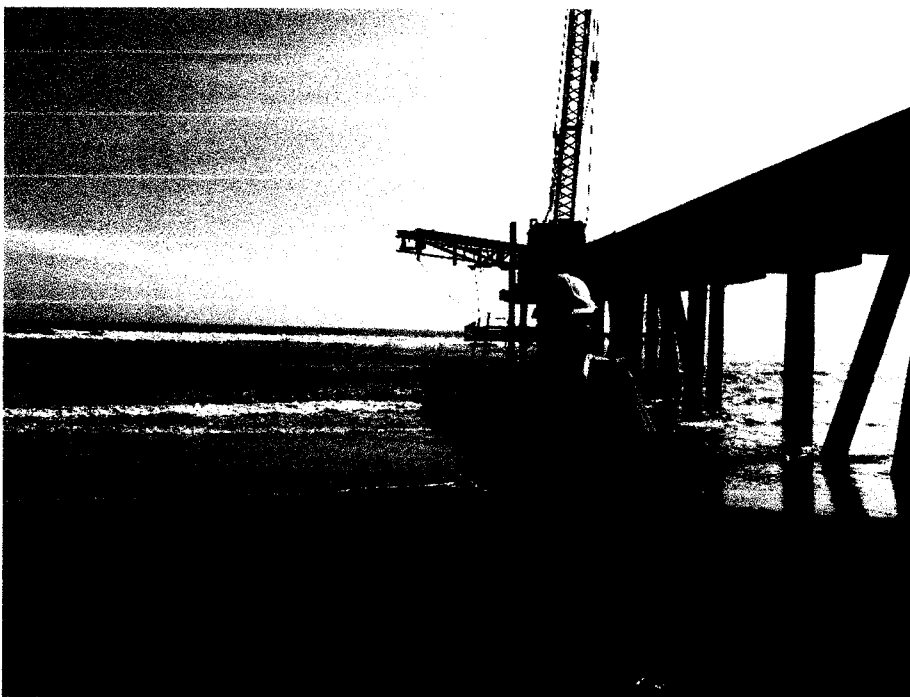
Otra vista de la misma operación
