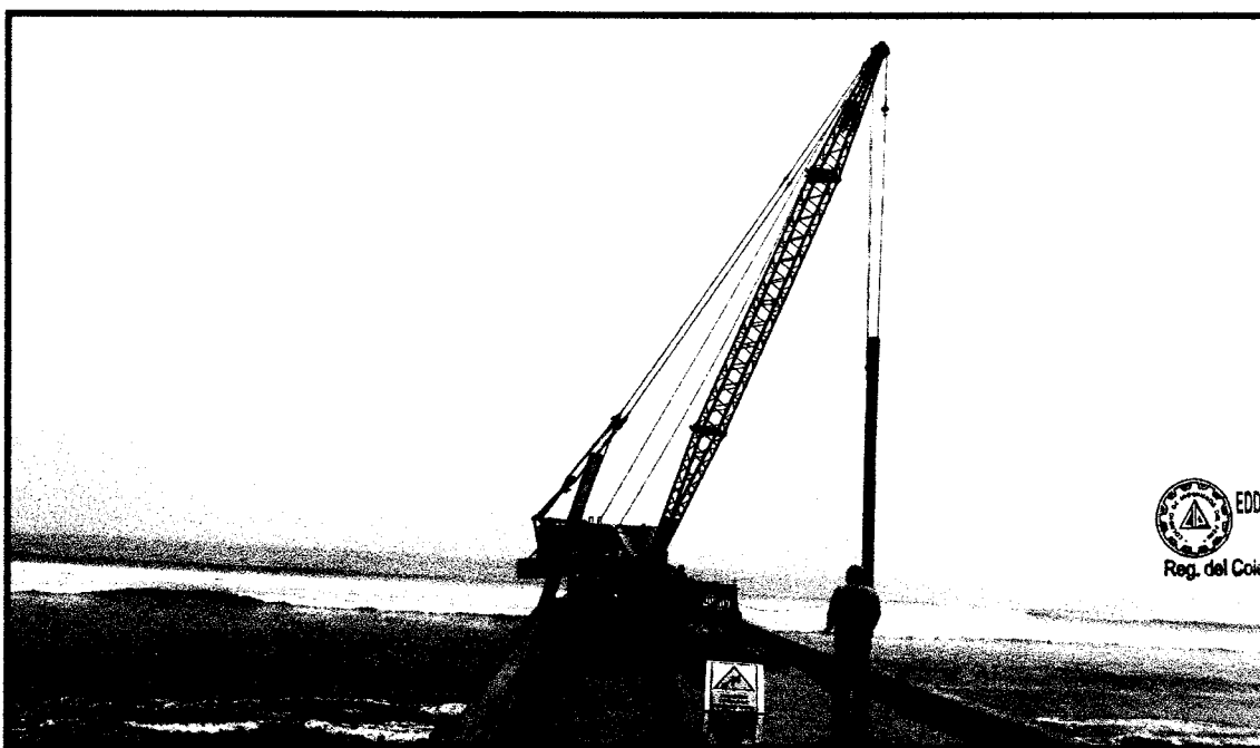
Imagen N°02 Trabajo de hincado de pilotes prefabricados con yvigías señalización de seguridad contra caídas.
