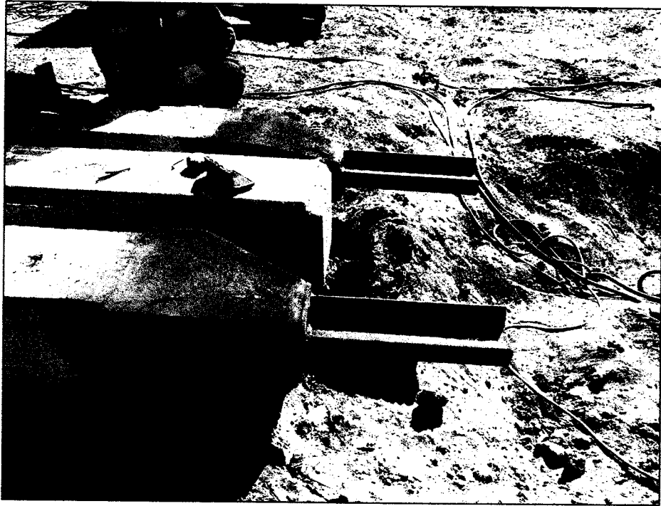
01.01.01.01 PUNTA METALICA DE PILOTE PARA FACILITAR HINCADO Y EL TANSPORTE.
