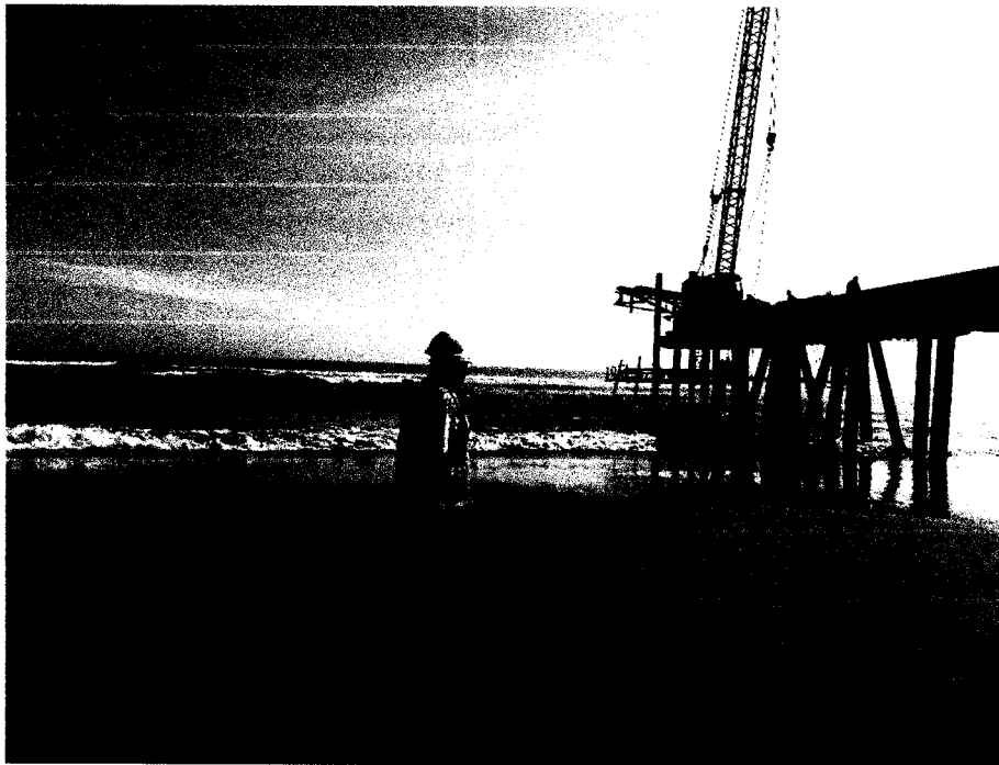
Supervisor verificando hincado desde playa de San Jose
